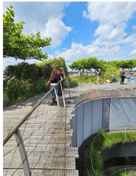
Pobytová zelená střecha na budově DRN na Národní třídě. Foto: Michaela Koucká
