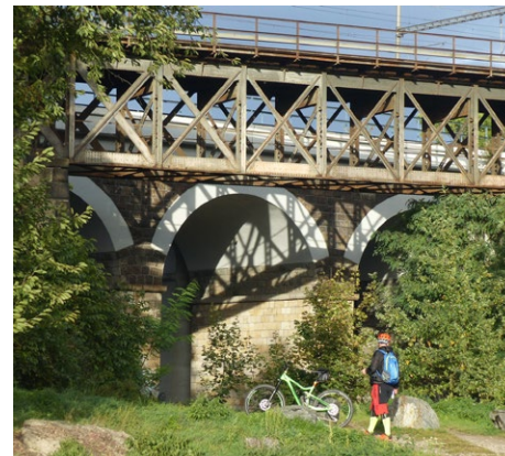
Trojměstí – trojice památkově chráněných železničních mostů.
