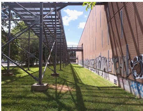
Objekt garáže na Praze 9. Foto: archiv Agentury Konikleč
