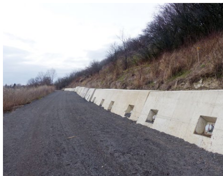
Kotevní zeď, bránící sesouvání bývalé slivenecké skládky.
