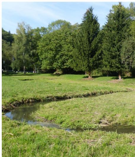
Při revitalizaci Šáreckého potoka se vytvořilo meandrující koryto a několik tůň.
