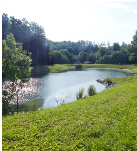
Retenční nádrž Nebužice slouží k předčištění dešťových vod a ke zmírnění povodňových průtoků.
