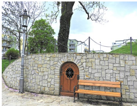
Pramen Barborka (stavba s jímkou upravená v letech 2017–2018 s finanční podporou hl. m. Praha a MČ Praha 19). Foto: Jana Stibralová
