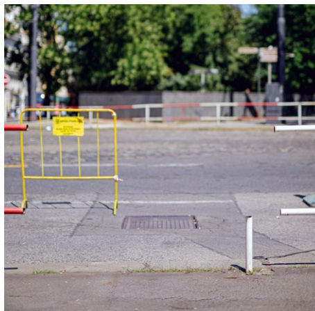
V červenci se na Karlově náměstí začaly budovat nové přechody pro chodce. Foto: Praha.eu
