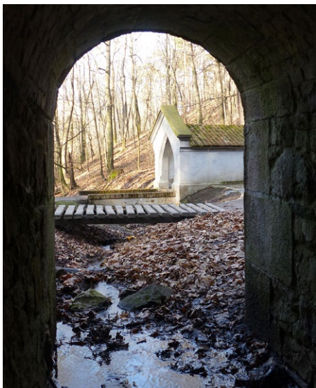
Průhled z tunelu pod železniční tratí k novogotické studánce.
