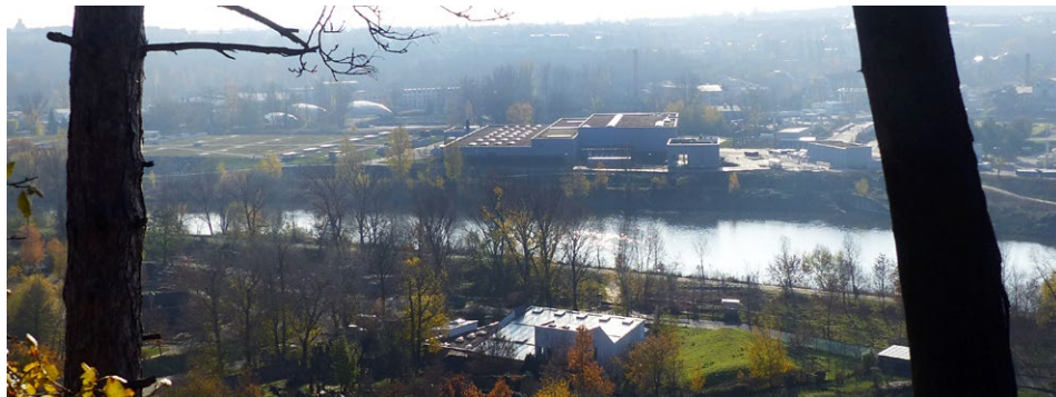
Pohled na Novou vodní linku z pražské zoo. Velká část technologie je pod pochozí střechou.
