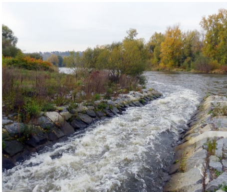
Výpust z Nové vodní linky. Voda by měla být zbavena fosforu a dusíku.
