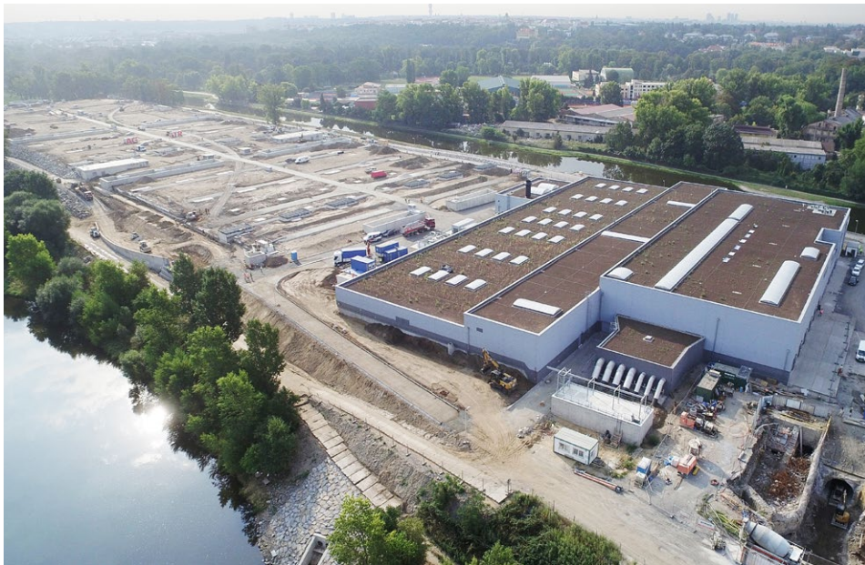
Výstavba Nové vodní linky.
