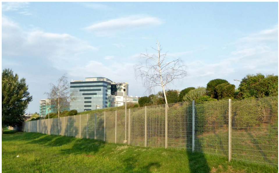
Zelená střecha v komerčním objektu bezprostředně navazuje na pás zeleně a vhodně tak dotváří veřejný prostor, Daimlerova ulice, Praha.
