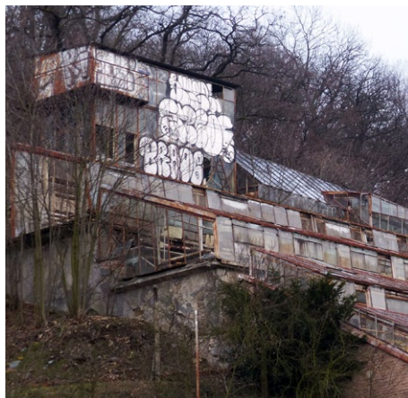
Sto let starý terasovitý skleník v Malešicích čeká demolice.
