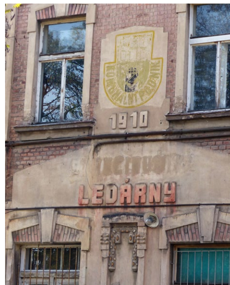
Pozdně secesní průmyslová stavba pomalu chátrá.
